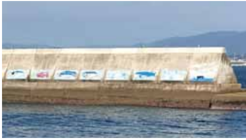
▲壁画全景、防波堤裏にも設置されている
